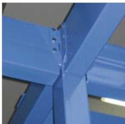
*Le système mécanique par autoserrage offre une grande sécurité et assure un temps de montage ultra rapide.*
